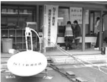
災害時における避難所への特設公衆電話の設置(NIT 東日本HPより)
